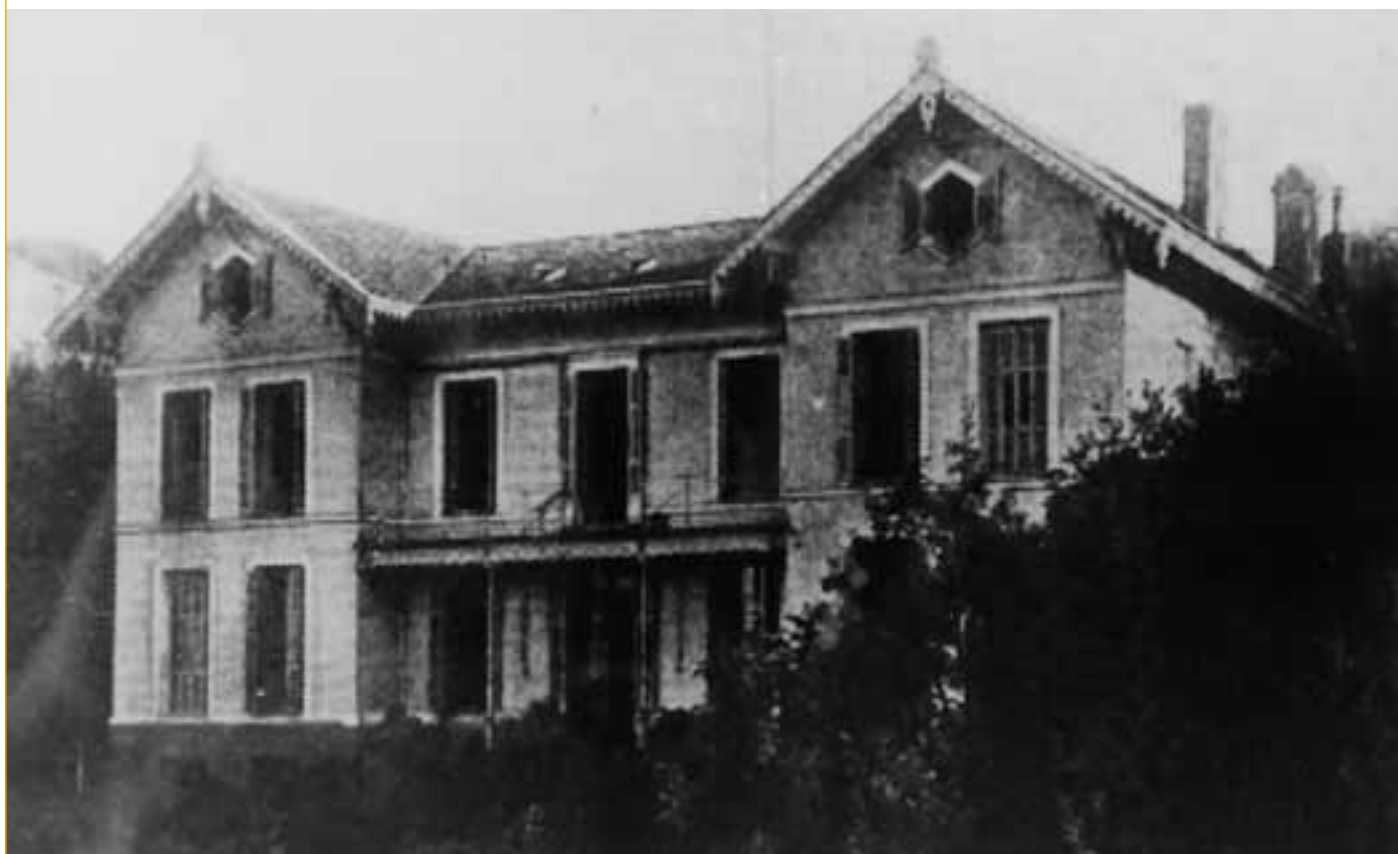
Vista de Villa Belén con su aspecto original, antes de la reforma actual.
